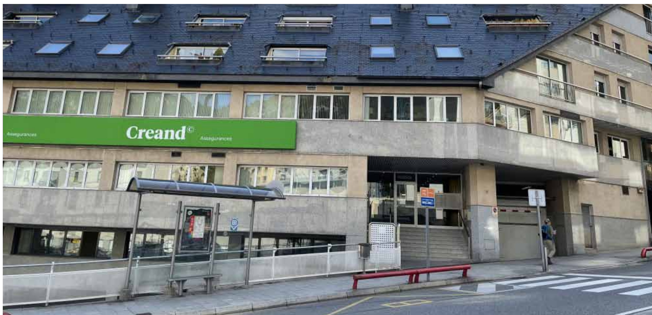
L'edifici Ròdol, situat al carrer Josep Viladomat d'Escaldes-Engordany.
