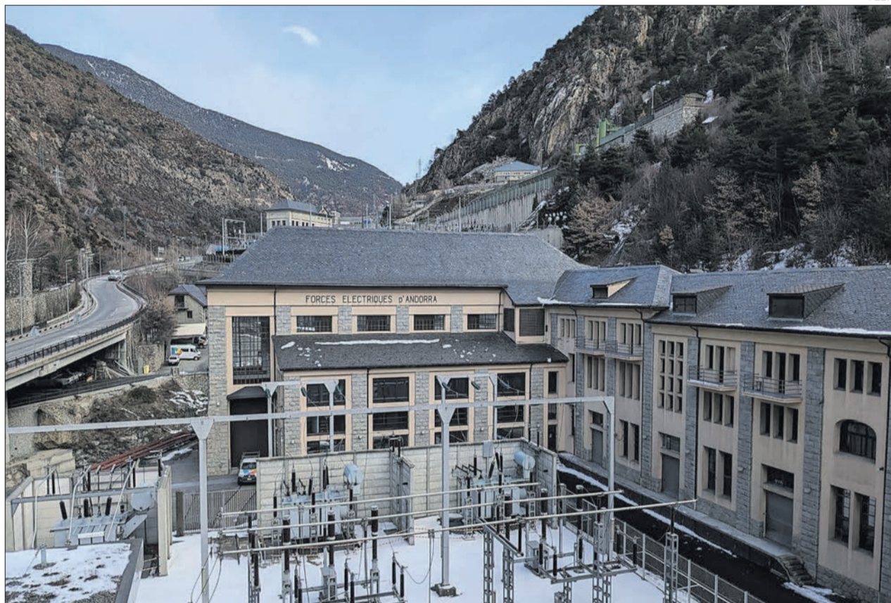
► L'edifici central de FEDA.
