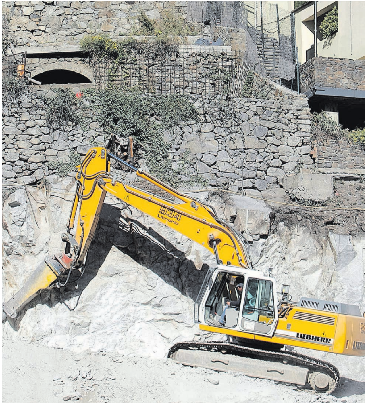
► Imatge de l'excavació d'una obra.
