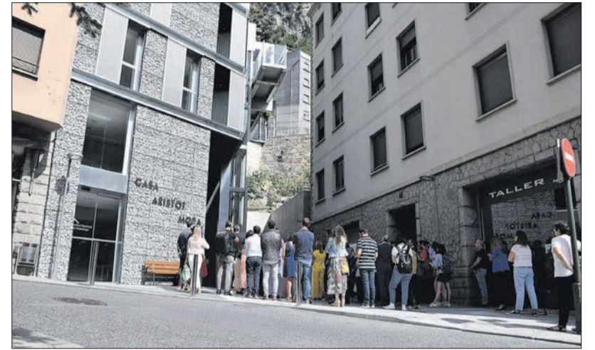
▶▶ Imatge de l'edifici de pisos de protecció pública Armor.
