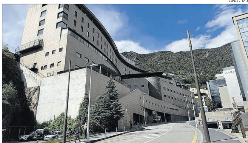
► Façana de l'Hospital Nostra Senyora de Meritxell.
